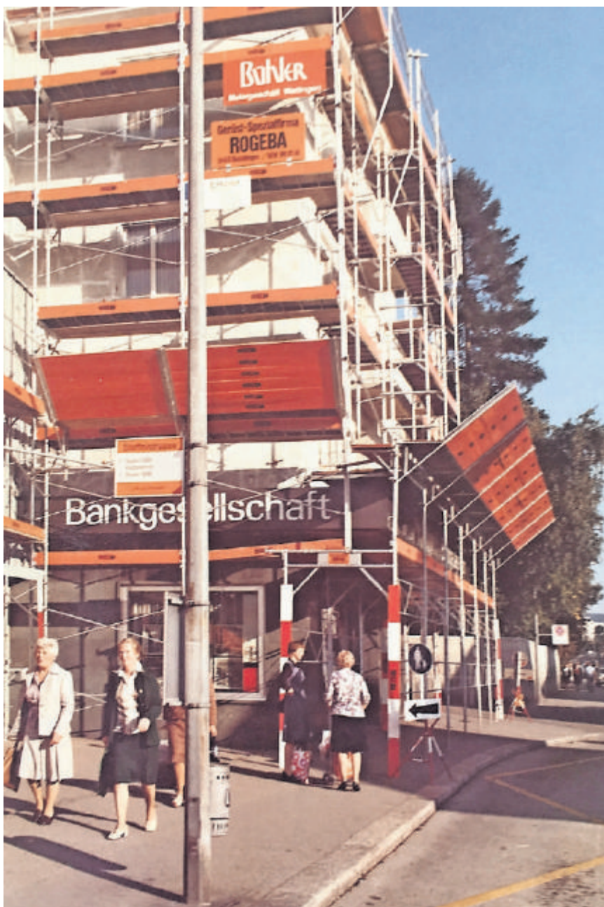
Eine Baustelle des damaligen Bühler Malergeschäfts 1961 in Wettingen.
